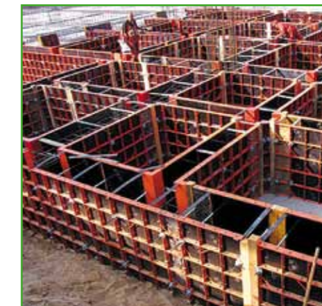
Система мелкощитовой опалубки при заливке фундамента под индивидуальное жилищное строительство
