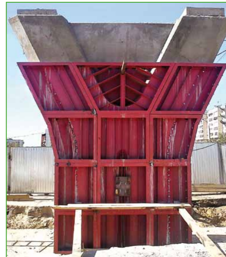
Система мелкощитовой опалубки при заливке фундамента под индивидуальное жилищное строительство
